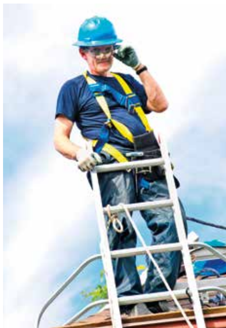
Mit der vorzeitigen Auflösung des Vertrags entfällt die Verpflichtung des Werkunternehmers zur Herstellung, Vollendung oder Verbesserung des Werks. Der Werkbesteller muss den auf die erbrachte Leistung entfallenden Aufwand bezahlen, auch wenn die Teilleistung für ihn wertlos ist.
